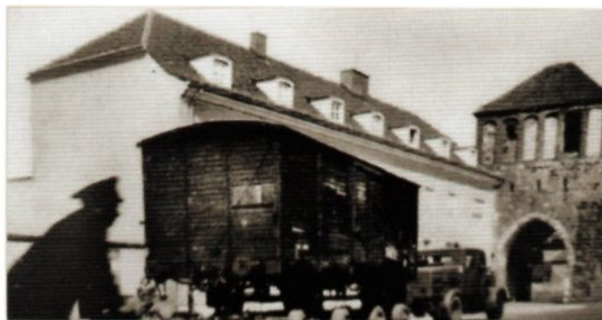
Vor dem Landsberger Tor ein achträdiger Culemeyer-Straßenroller auf dem Weg zum Fliegerhorst. (Stadtmuseum Strausberg)
