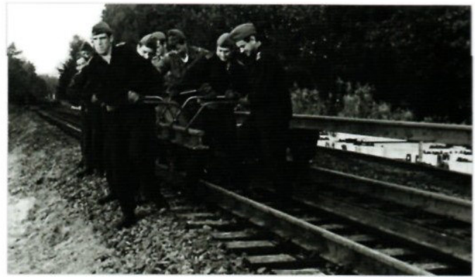
Das Eisenbahnpionierausbildungsregiment 2 errichtet auf Weisung des Ministers innerhalb von drei Wochen den S-Bahn-Haltepunkt „Hegermühle“.
